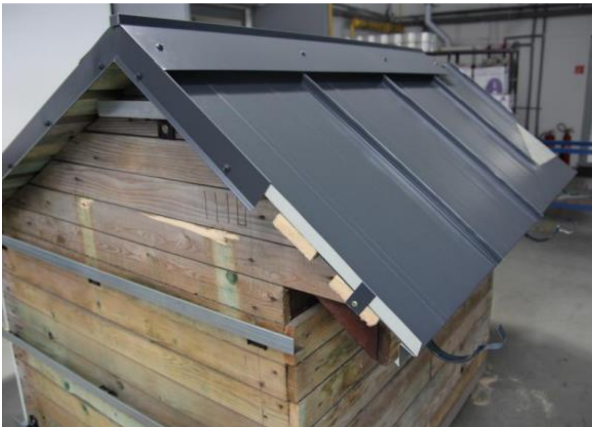
Ukážka uloženia ukončovacej lišty pri falcovanej strešnej krytine.
