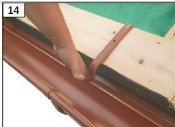
Na prichytenie žlabu sú určené príchytky na žlabovom háku. Dbať na presné dosadnutie konca háku do predného návalku žlabu.
