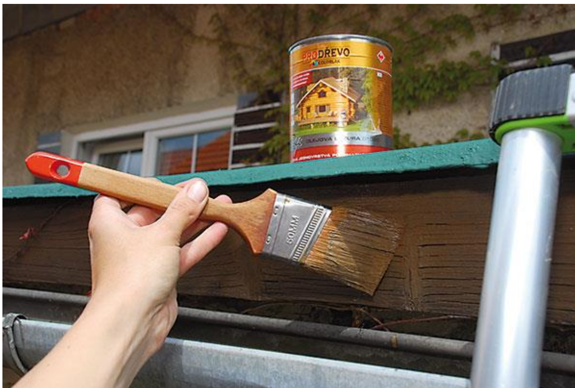
Ilustračný obrázok lakovania dreveného podbitia strechy lazúrou.
