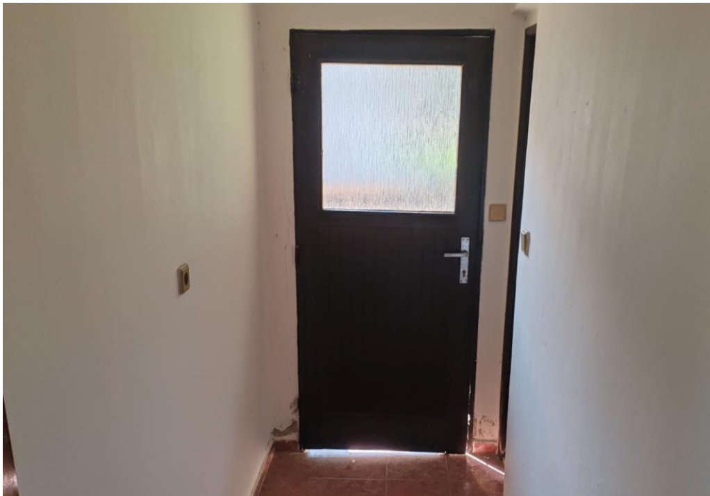
Pohľad z interiéru na nedoliehajúce dvere (bočný vstup z južnej strany).
