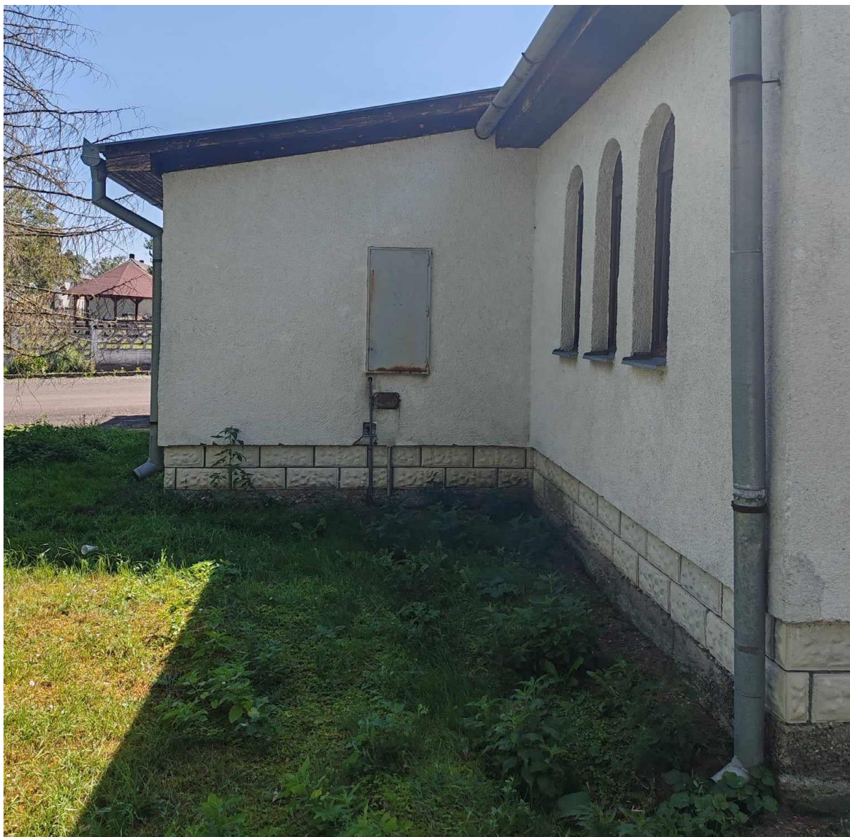
Existujúca zemná elektrická prípojka s konzolou na západnej stene fasády.
