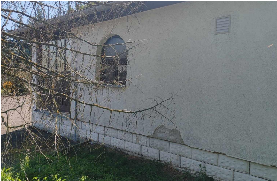
Viditeľné opadávanie existujúcej brizolitovej fasády.
