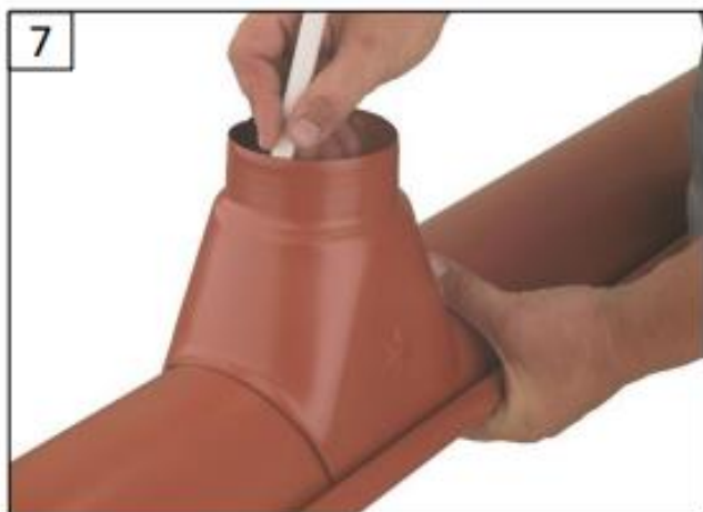
7 Stanoviť umiestnenie hrdla odkvapovej rúry Naznačiť výrez pre otvor odtoku s pomocou hrdla žlabu
