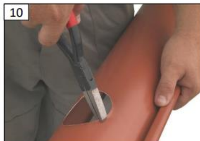
10 Miernym sklepaním vytvarovať vystrihnutý okraj otvoru smerom dole ako odkvapovú hranu pre vtekajúcu vodu
