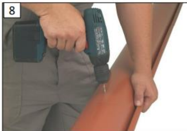
8 Vyvŕtať dieru k vystrihnutiu odtokového otvoru v žľabe nožnicami na plech
