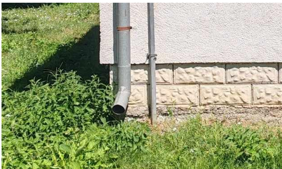
Chybná realizácia zvodov – zvodov nie sú napojené na existujúci trativod.
